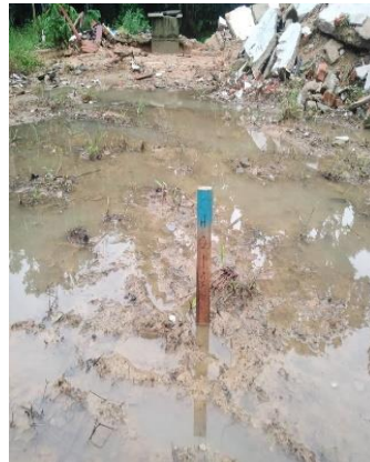
Fig. 3: Chainage peg
