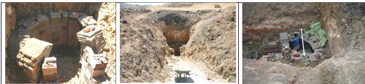
Début de construction du four, la chambre à feu (Bit Ennar) à parois en briques pleines (par manque on a utilisé les briques creuses) adossées aux parois de la fouille. Un chemin est préparé
